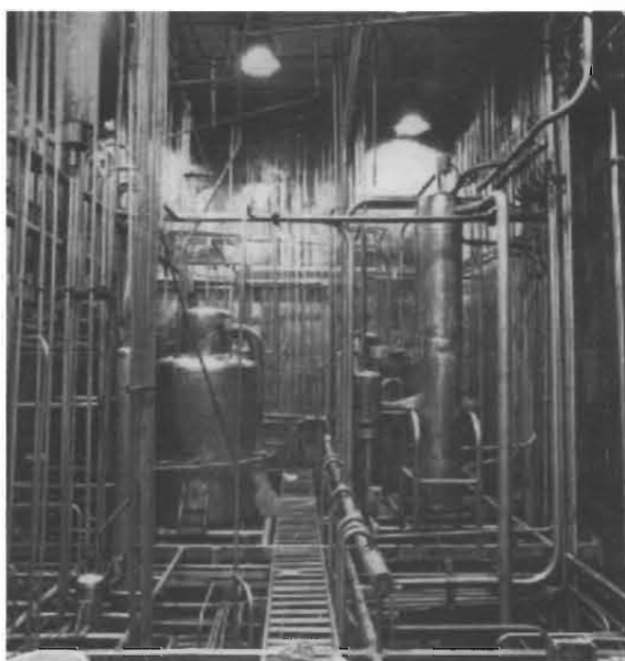
ホットケープ 解体前
